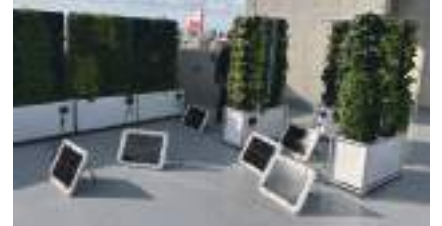
● 休憩時には屋上緑化を見学。 株プランネットのみどりスタックを利用しており、ソーラー電源で水の循環をしている
